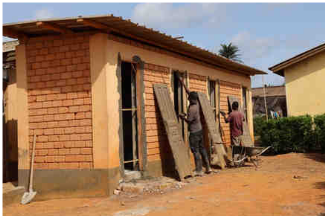
△ Réhabilitation de latrines à Héké 1
