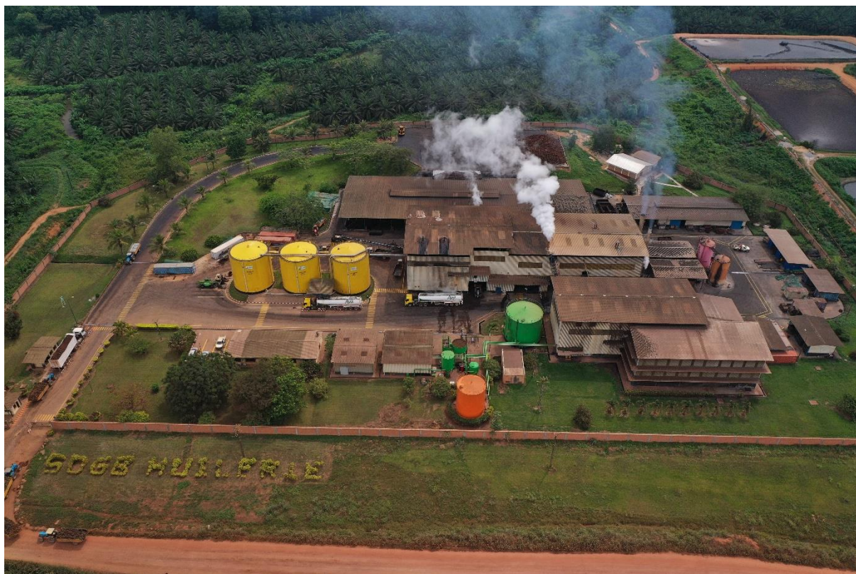
Vue aérienne de l'huilerie de la SOGB
