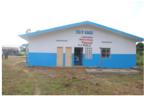
Une vue du bâtiment offert par la SCC au CSU d'Adaou
