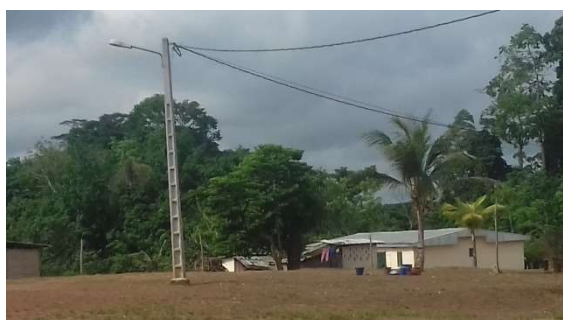
Connexion du village HEKE au réseau électrique national
