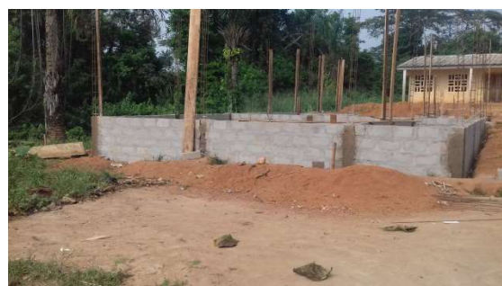
Un bâtiment de 3 classes en construction dans un village AVD (TRAHE)
